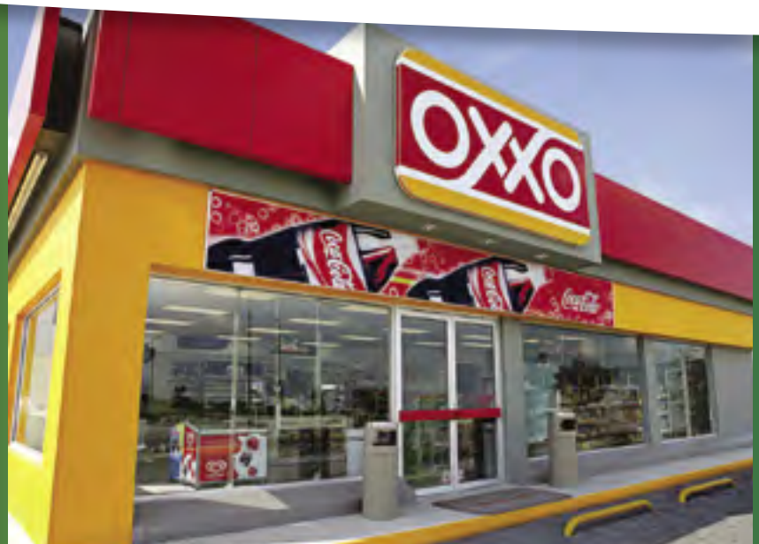
Tienda OXXO > Monterrey, México
